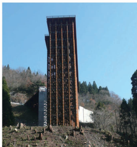
富山/利賀ダム 杭長48.0m
